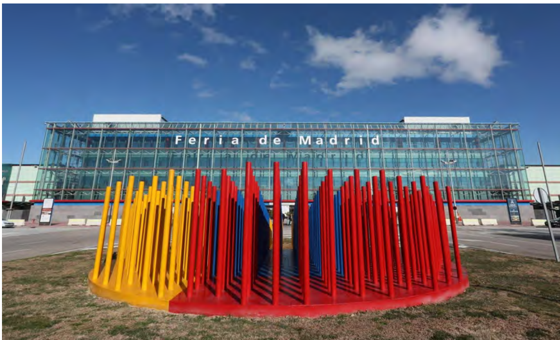
Source: Fig. 4. Fachada de los recintos de Ifema en el Campo de las Naciones. Photo provided by EL PAÍS. Credit: Kike Para Photography. February 2008. https://elpais.com/ccaa/2018/02/07/madrid/1518003447_566143.html Accessed: 7 November 2020.
